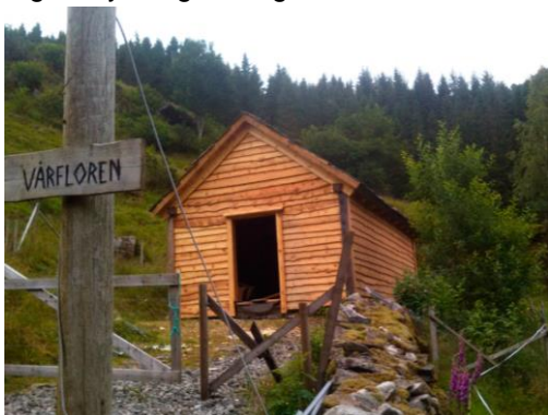
Fig. 3 Restaurering av vårfloer
